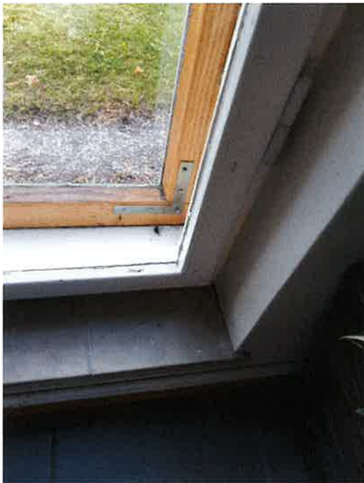
Ikkunoiden F101, F102, F103 ja F104 ikkunapenkki on Harmaankirjavaa keraamista laattaa. Tässä F102.
