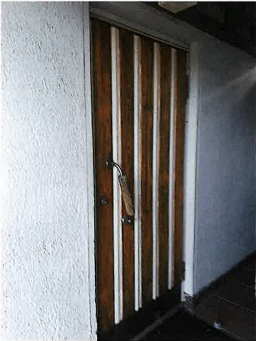
Henkilökunnan sisäänkäynnin ovi, ikkunan F103 vieressä.
