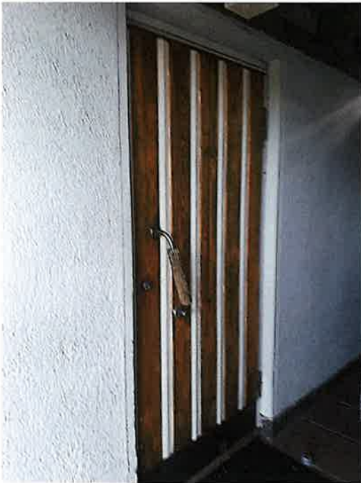
Henkilökunnan sisäänkäynnin ovi, ikkunan F103 vieressä.
