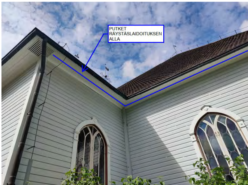
Kuva 2. Ulkopuolisten sprinkleriputkien sijoitus.
